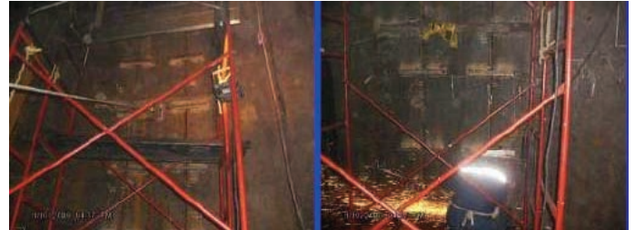
PLANCHA COLOCADA ENTRE LOS AGUJEROS DE COLADA
