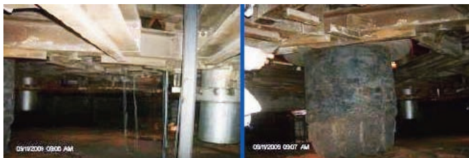
INSPECCION DE ESTRUCTURA METALICA DE BÓVEDA
